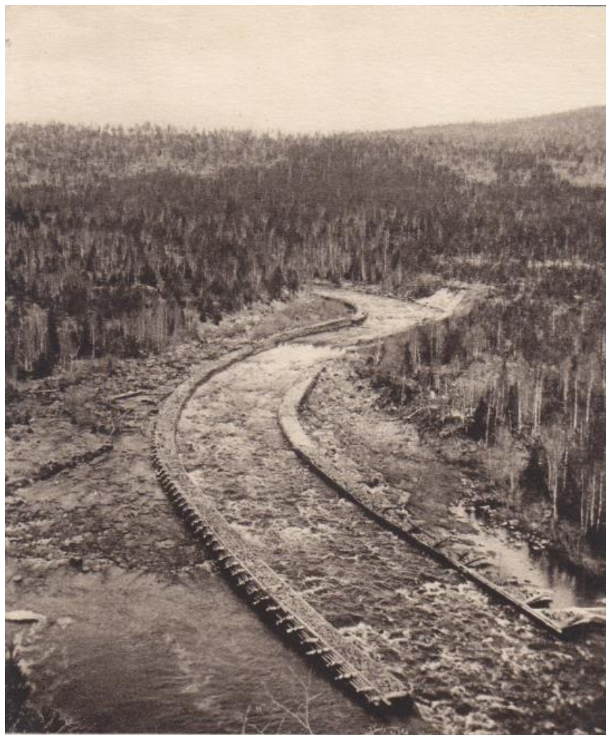
LEDDAMMAR i Skrövfallet, Gällivare. NORRBOTTEN o. Vattendragen i övre Norrland ha i stor omfattning utbyggt till flottleder. I kusttrakterna lämna skogarna god avkastning, men inne i lappmarkerna äro de delvis av mindre värde. N. LAPPLAND 16 STF FOTO H. SALLING
