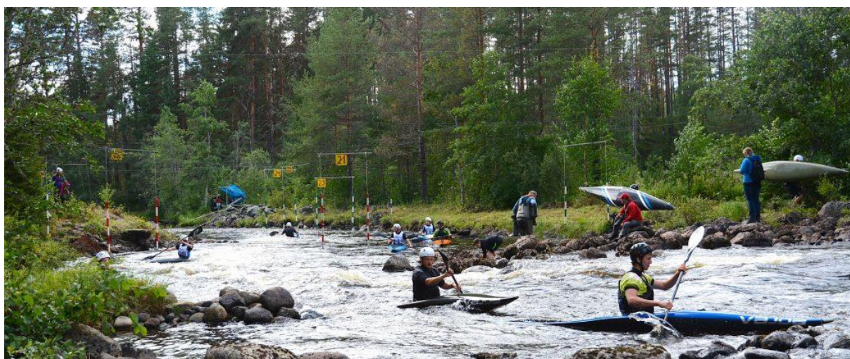
Bild 9. Kanotslalombanan i Åman, ett biflöde till Vindelälven. Vid kanterna ligger korta stenbarriärer vinkelrätt mot strömmen. Dessa ger bakvatten som är stora nog för att paddla uppströms genom att sicksacka mellan bakvattnen på ömse sidor. Foto: Bo-Marcus Lidström
